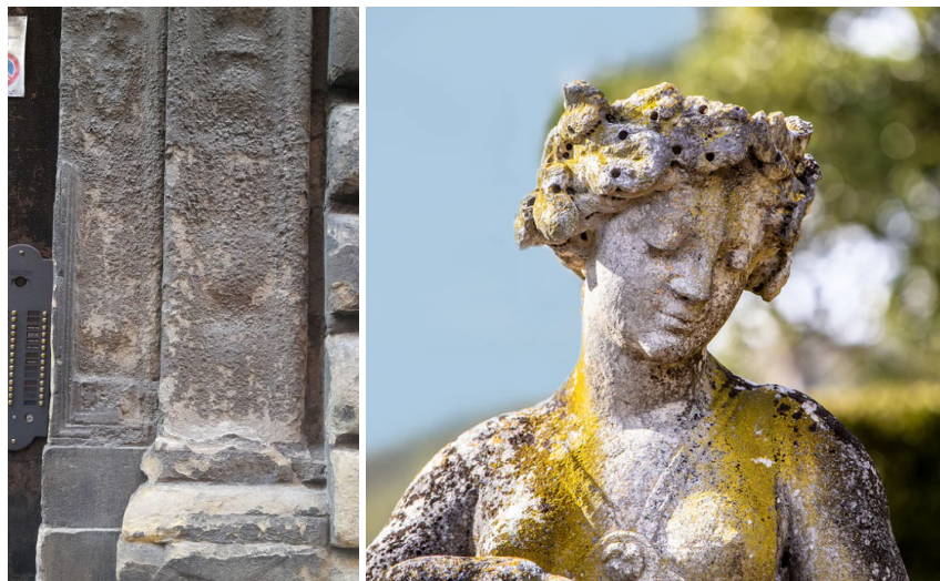
Figura 5. Sn, esempio di crosta nera; dopo il distacco – spontaneo – o la rimozione della crosta il substrato lapideo si mostra gravemente disgregato e pulverulento. Foto: Teknoring. Web. < https://www.teknoring.com/guide/guide-architettura/il-degrado-delle-superfici-di-architettura-secondo-la-norma-uni-11182/ >. Dx, presenza di licheni su una statua in marmo. Foto: Valsanzi biogiardino. Web. < https://visit.valsanziobiogiardino.com/products/standard-admission-child?logged_in_customer_id=&lang=it >.
