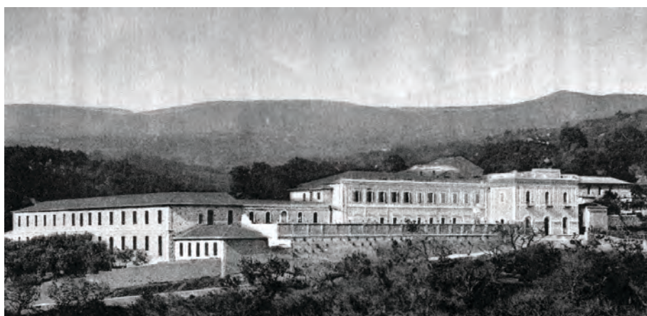
Figura 2. Ospedale psichiatrico di Catanzaro in Girifalco: veduta (Fonte: www.architetturemanicomiali.altervista.org )
