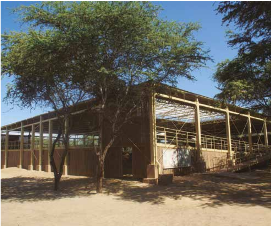
Panorámica de la cobertura definitiva desde el Noroeste, diseñada por el Arq. Raúl Zamalloa Cáceres (fotografía de Alfredo Narváez)
